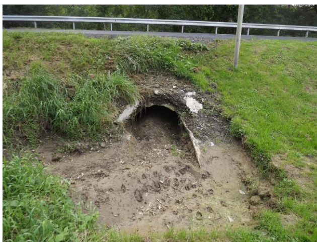
A 82. sz. fkl. út alatti feltárt rossz állapotú áteresz Kardosrét déli szélén
