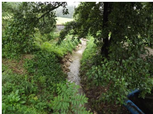
Az árok közút és vasúti áteresz közötti szakasza
