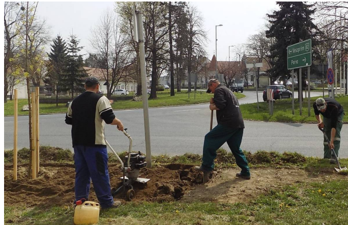
A „Zirci Városüzemeltetés” Nonprofit Kft. munkatársai végzik a telepítéshez szükséges földmunkát a Rákóczi téren, a negyvenlakásos épület előtt – látványos zöld sziget jön létre
