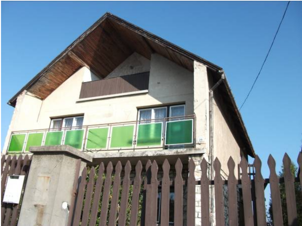
Családi háznak épült, végül a zeneiskolások lakták be a Deák Ferenc utca 26. szám alatti ingatlant
