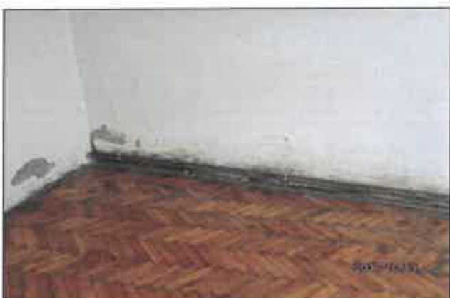
Több helyen felázási nyomok
