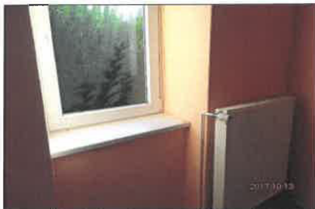
Utcafronton műanyag szerkezetű, hőszigetelt üvegezésű ablakok, acéllemez lepradiátor hőleadók
